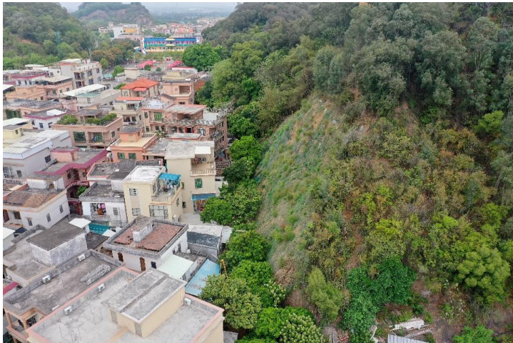
照片 3 勘查边坡周边环境(镜向 10°)
