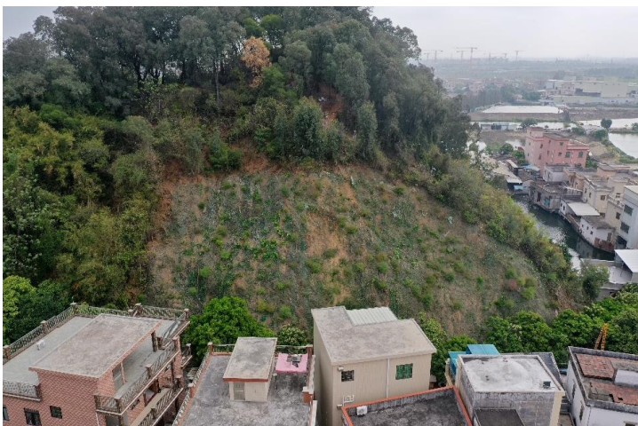
照片 4 勘查边坡周边环境(镜向 100°)
